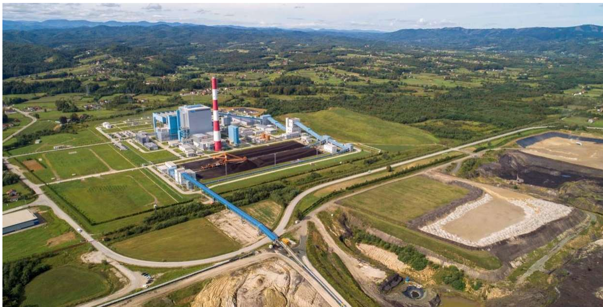
Слика 2. Земљиште у процесу рекултивације око термоелектране и депоније ч.о.с.
