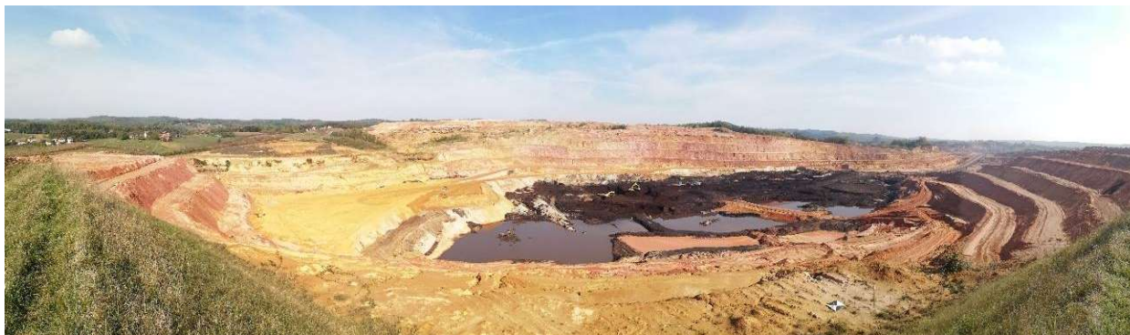
Слика 1. Фотографија дијела п.к. Рашковац (коп 1) са завршним косинама у процесу рекултивације
