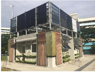
Слике 26-28: Продуктивне фасаде (са и без балкона) на тест-згради T^2 Lab на кампусу Националног универзитета у Сингапуру [14] (фото кредит: проф. Абел Таблада, јануар 2019)
