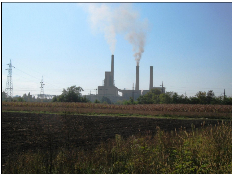
Slika 1. Termoelektrana „Kolubara“ u Velikim Crljenima kod Lazarevac Picture 1. Thermal power plant “Kolubara” in Veliki Crljeni near Lazarevac, Serbia
