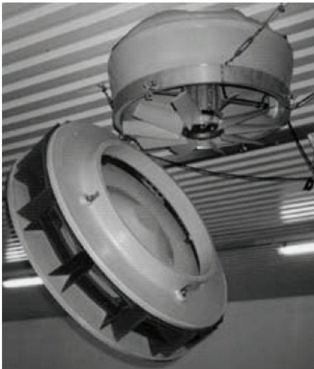
Sl. 7. Usmerivač vazduha na ventilatoru za uvođenje vazduha u objekat
